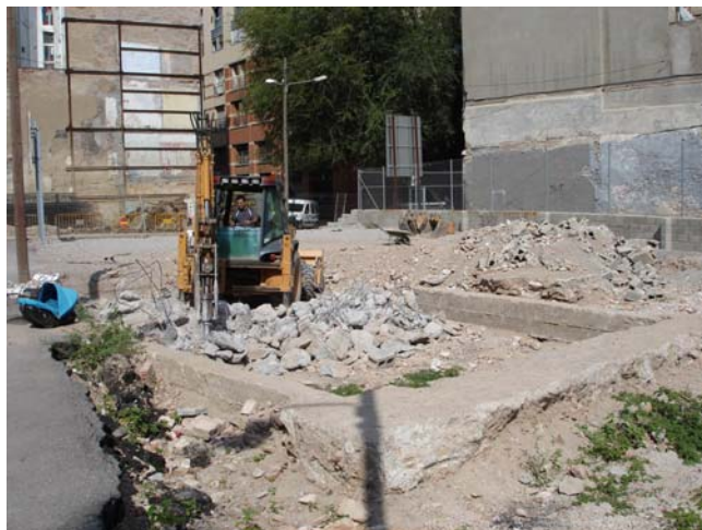
Vista dels treballs mecànics de desmuntatge d'estructures.
